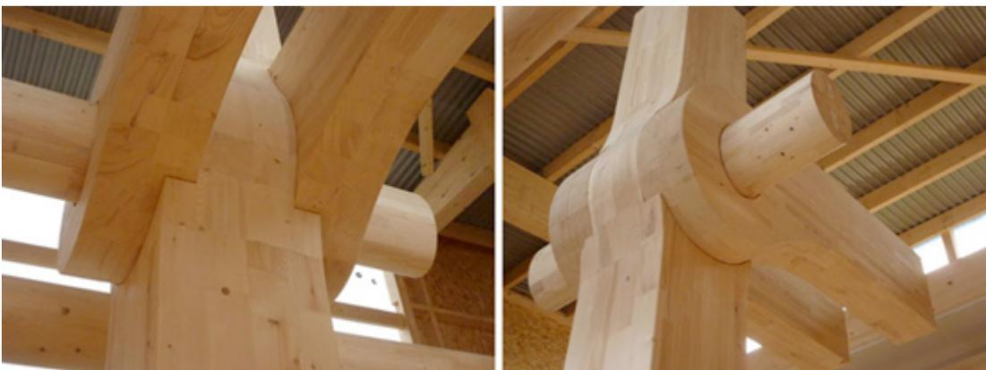
Der kraftschlüssige Holzknoten, unten der gefräste Zapfen aus Buchenlamellen
