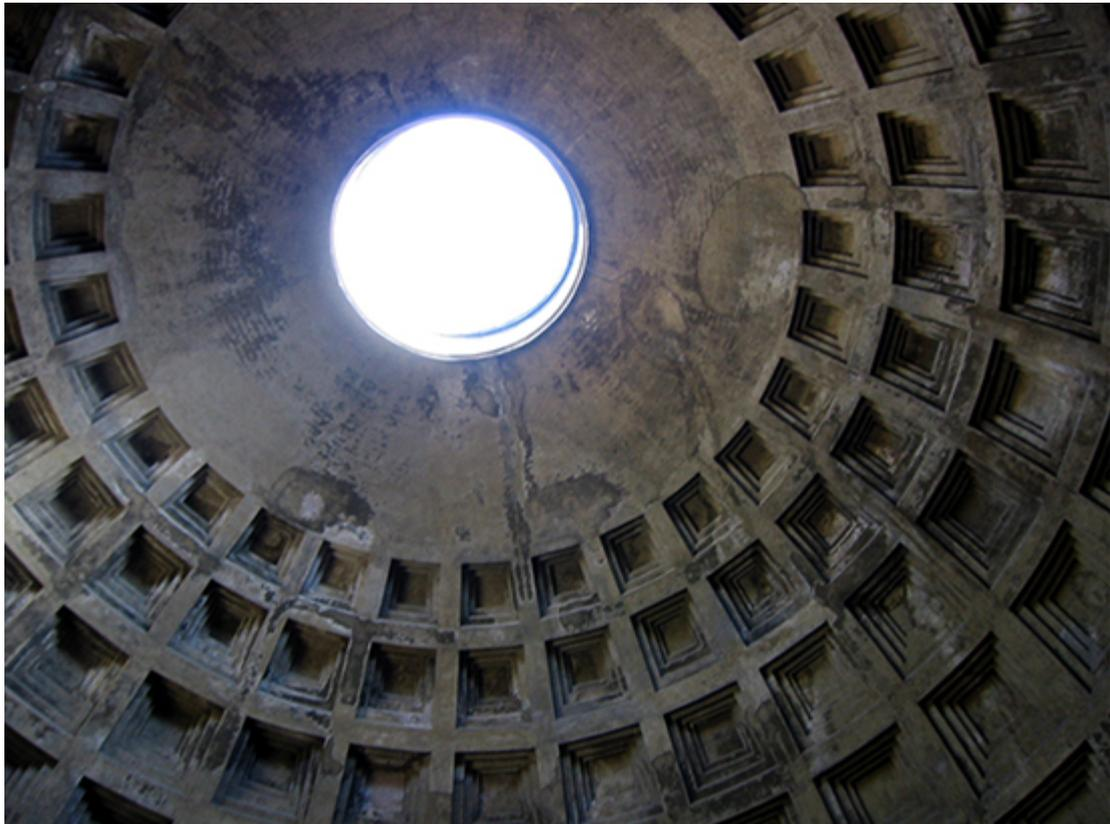
Pantheon Rom, Kuppel Durchmesser etwa 43.45 m, Okulus Durchmesser 9.00m
