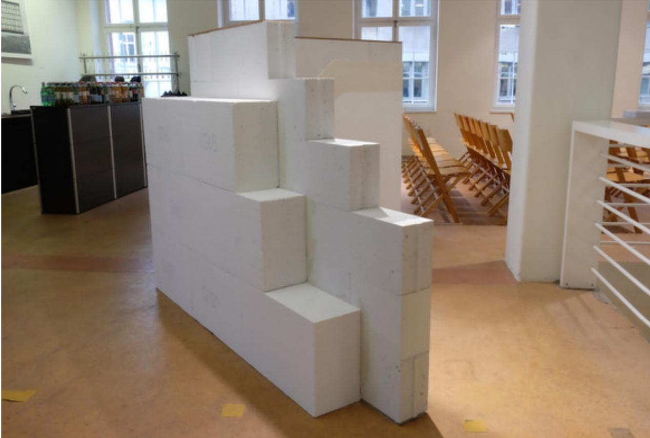
*Mock-up eines Wandsystems aus YTONG P Stein und Multipor Dämmung*
