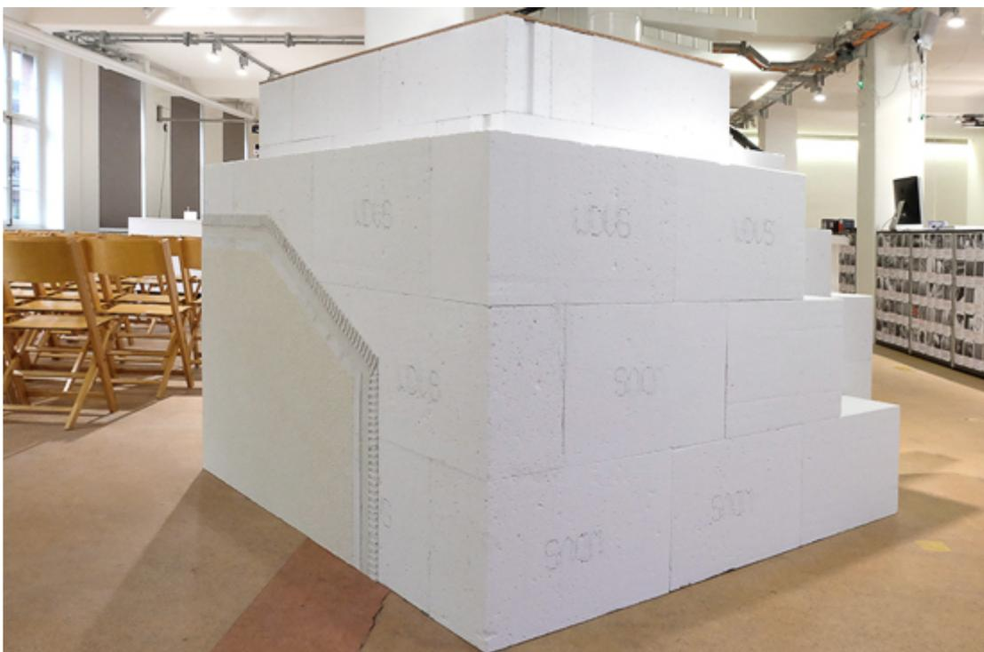
Mock-Up mit tragenden Ytong Porenbetonsteinen und Mutipor Dämmplatten in der SBCZ, 2017
