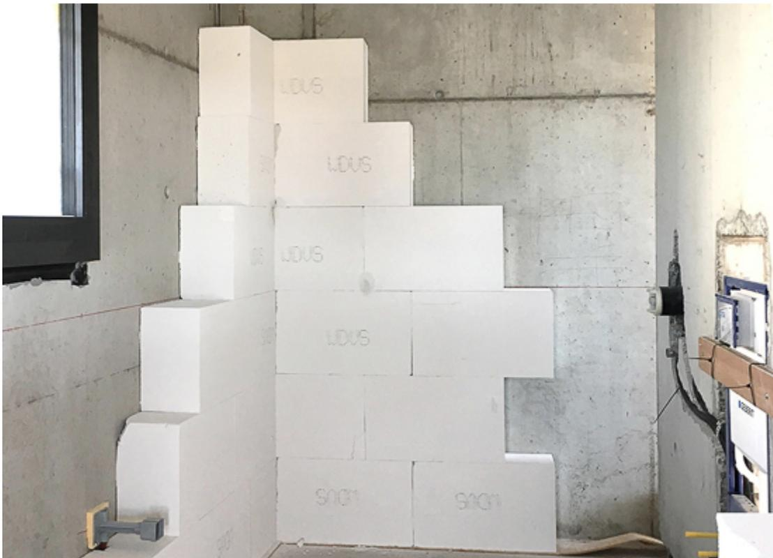
Multipor Innendämmung auf Betonwand
