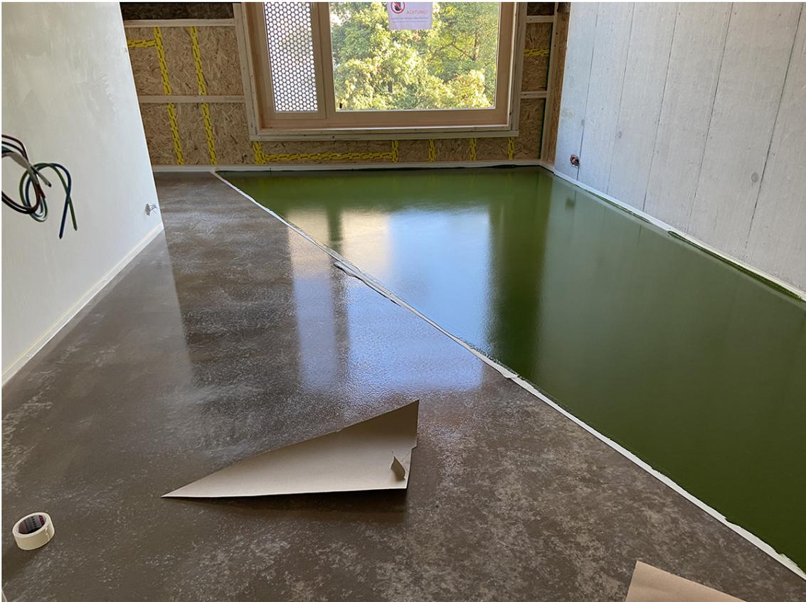
Der Flüssigboden wird nach Farbabschnitten aufgebracht. Baustelle Kindergarten Looren, 2022 Bild: L3P
