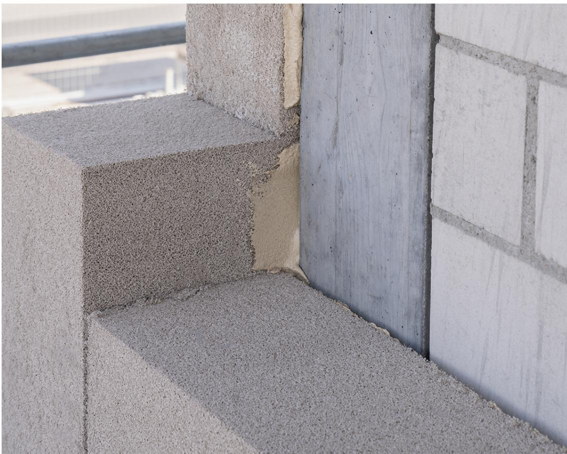
Der kaltgeschäumte Mineraldämmstoff wird mit Mörtel auf der Baustelle verarbeitet Bild: swisspor
